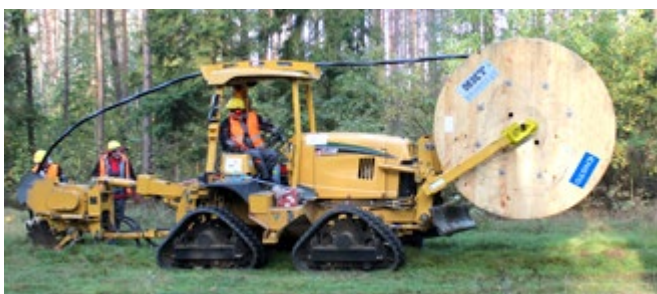
Rys. 4. Pługoukładacz wibracyjny z wysięgnikiem na bębny kablowy z kablem trzyżyłowym AXAL-TT-PRO
