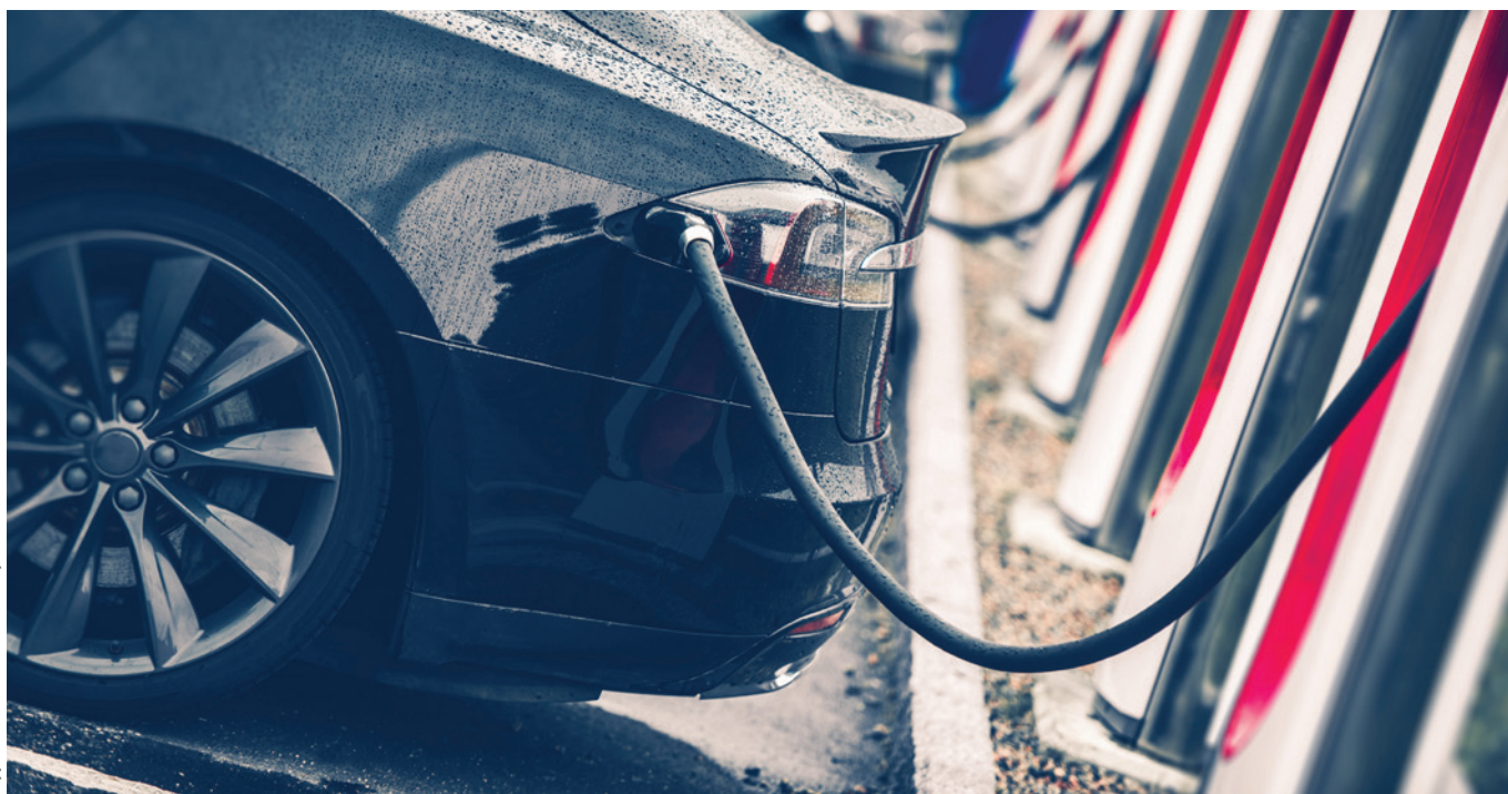
Budowa punktów ładowania – zgodnie z projektem – nie wymaga decyzji o pozwoleniu na budowę ani zgłoszenia
