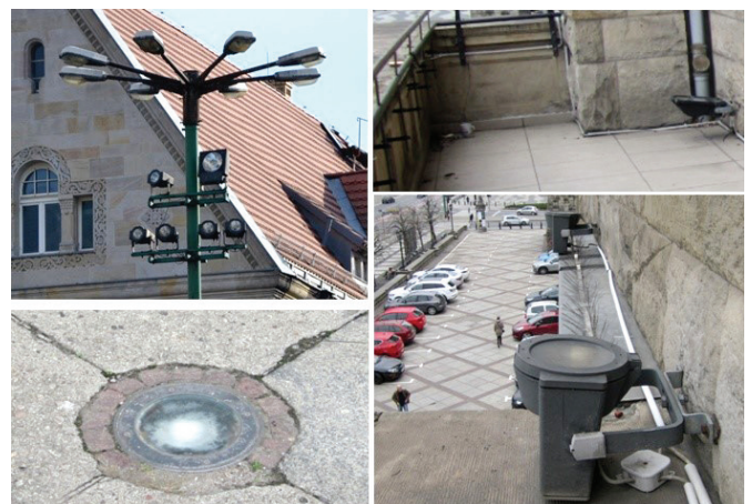
Rys. 7. Montaż opraw do iluminacji Zamku Cesarskiego w Poznaniu
