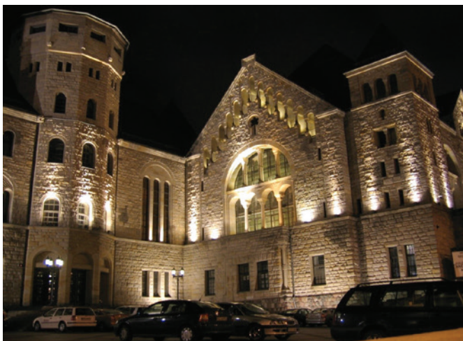
Rys. 8. Iluminacja frontowej elewacji Zamku Cesarskiego
