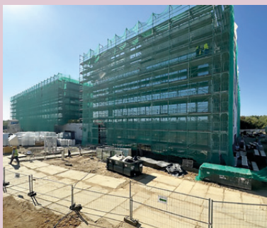
Zakończenie budowy nowego obiektu PSE w Radomiu przewidziane jest na przyszły rok
