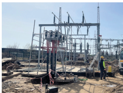
Stacja 110/15 kV Łomża 1 w trakcie prac modernizacyjnych
