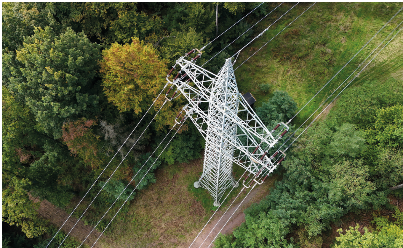
Resort energii zwrócił się do PTPIREE o przekazanie informacji związanych z procesem realizacji inwestycji i projektów realizowanych przez OSD
